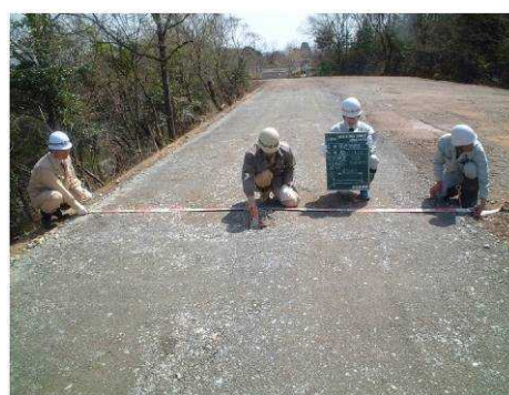
実施後 (幹線水路・パイプライン)
