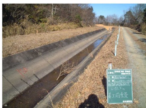
実施前 (幹線水路・開水路)
