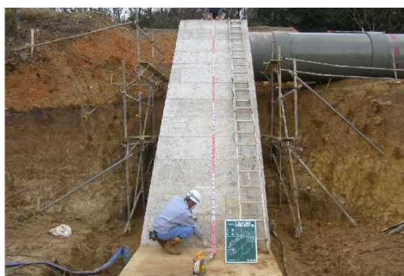
コンクリート基礎の施工
