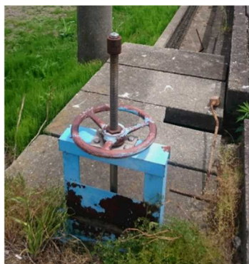
改修前の分水工
