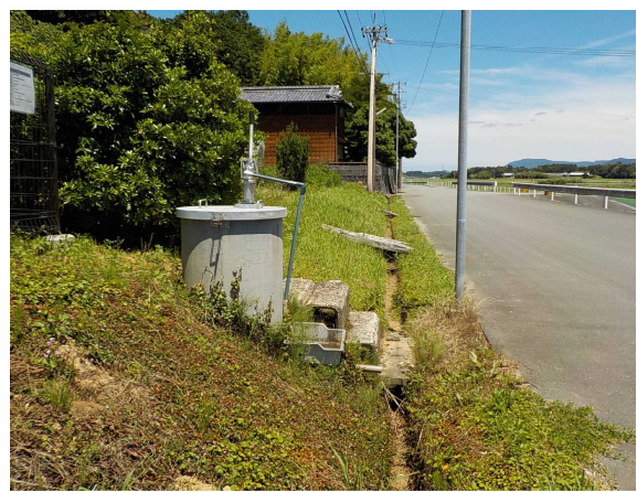
手押しポンプ（営農用水）
