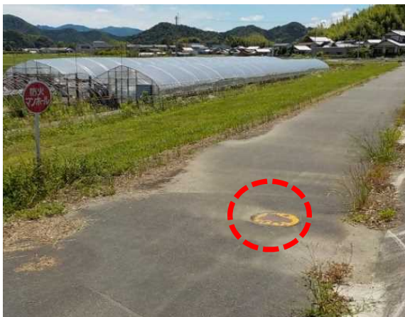
防火用マンホール（防火用水）
