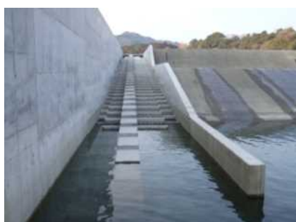
下流放流工（魚道）
