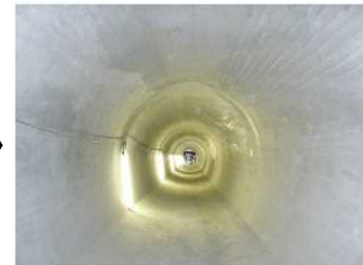
内空断面の拡幅
