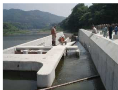
新設魚道遡上調査
