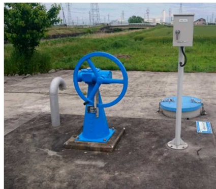
改修後の分水工
