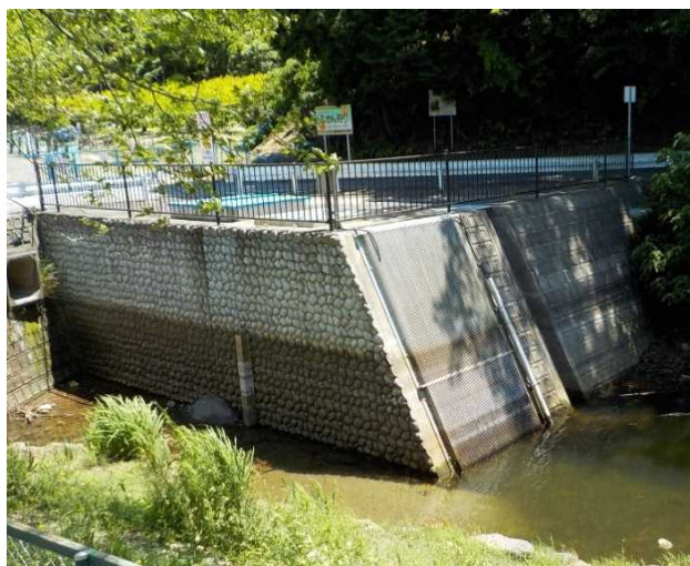
五桂池注・取水施設
