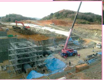
<実施中：取水工の施工>
