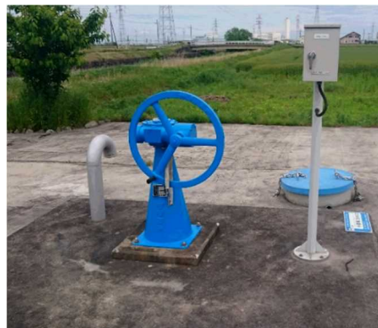
改修後の分水工
