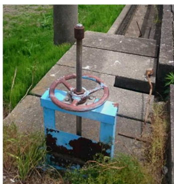
改修前の分水工
