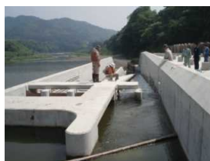
新設魚道遡上調査
