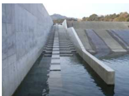
下流放流工（魚道）
