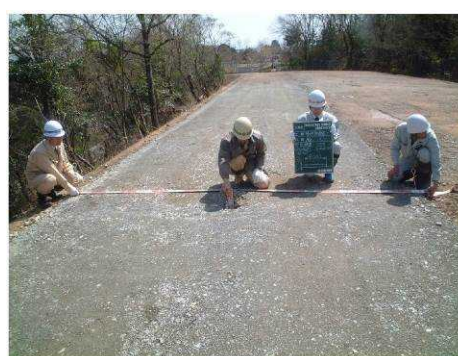
実施後 (幹線水路・パイプライン)
