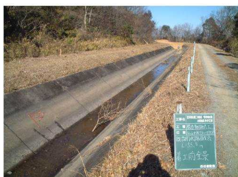
実施前 (幹線水路・開水路)
