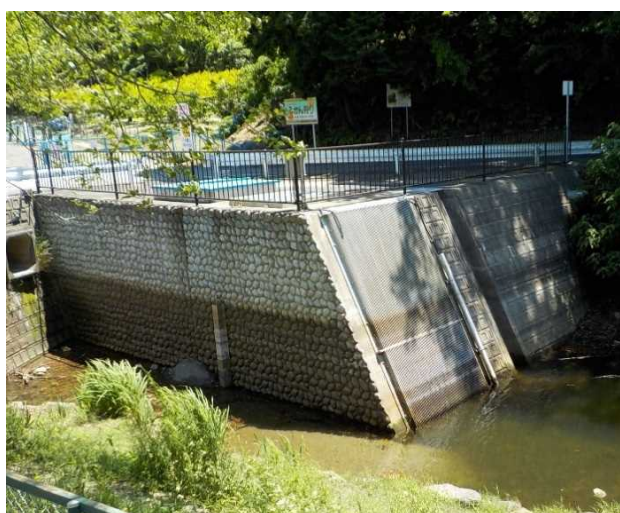
五桂池注・取水施設
