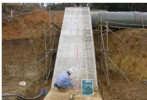
コンクリート基礎の施工
