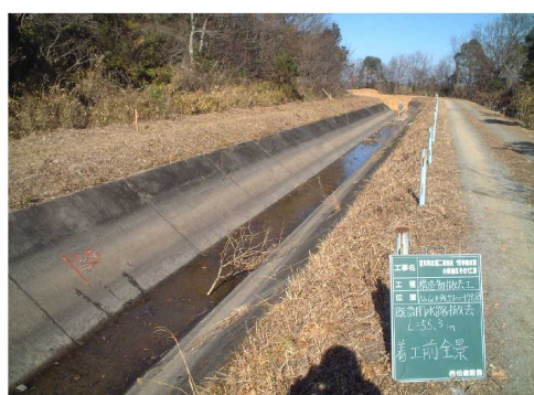
実施前 (幹線水路・開水路)
