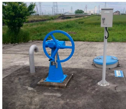
改修後の分水工
