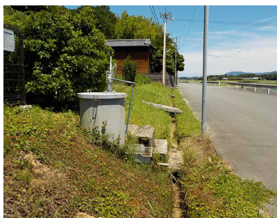
手押しポンプ（営農用水）
