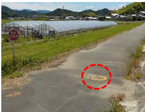
防火用マンホール（防火用水）
