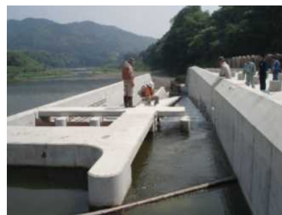
新設魚道遡上調査
