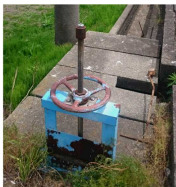
改修前の分水工
