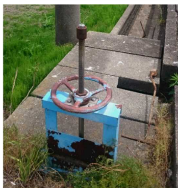
改修前の分水工
