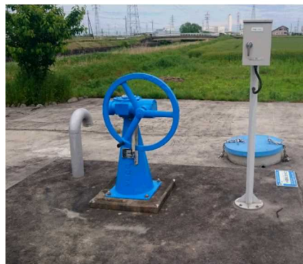
改修後の分水工
