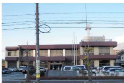
中央管理所（宮川用水土地改良区）
