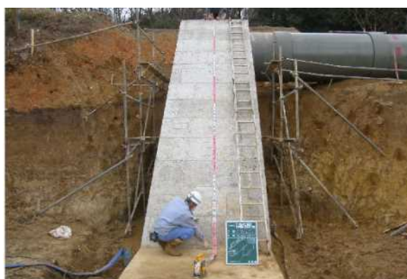
コンクリート基礎の施工
