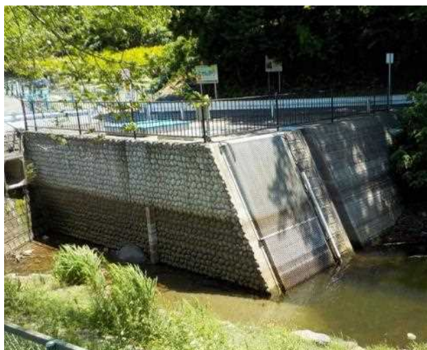
五桂池注・取水施設
