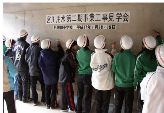
小学生による工事見学会
