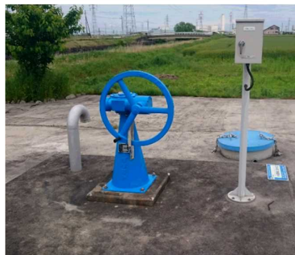
改修後の分水工
