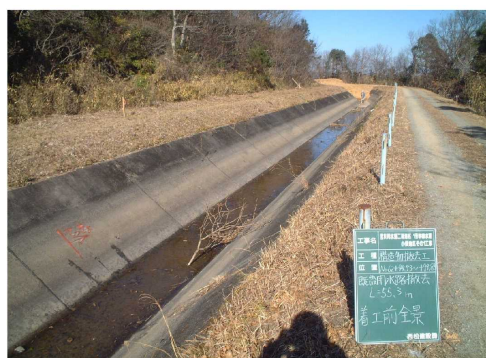
実施前 (幹線水路・開水路)
