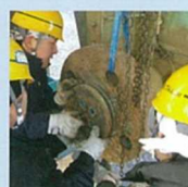
扉体の補修 (主ローラの交換)
