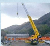
ゲート扉体の更新
