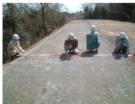
実施後 (幹線水路・パイプライン)
