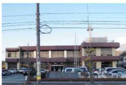
中央管理所（宮川用水土地改良区）
