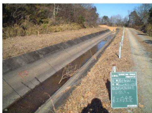
実施前 (幹線水路・開水路)
