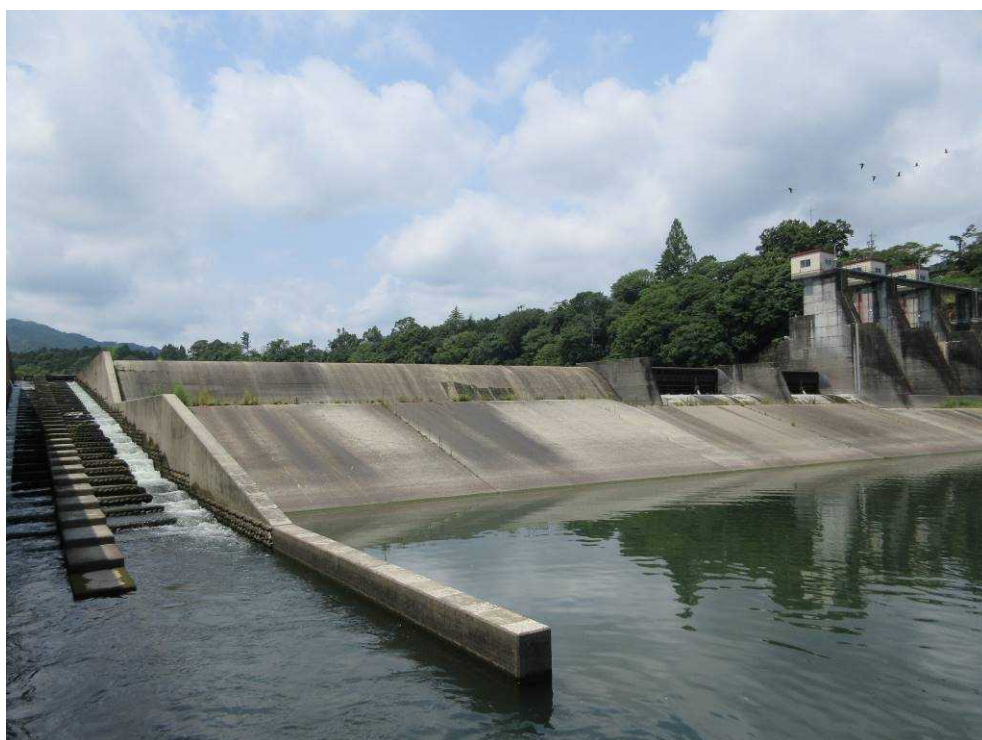
あお 粟生頭首工
