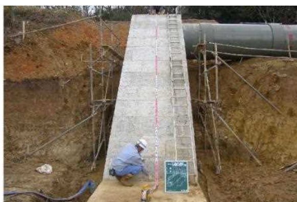
コンクリート基礎の施工
