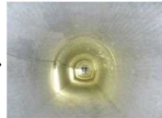
内空断面の拡幅
