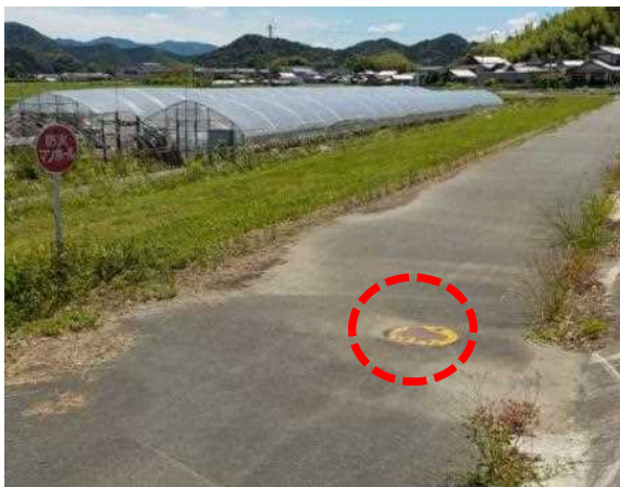
防火用マンホール（防火用水）
