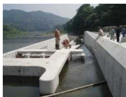
新設魚道遡上調査
