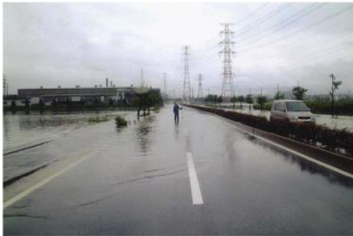
豪雨時の状況 (大垣環状線 静里地区内) H16年10月 台風23号
