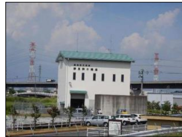
静里排水機場(上屋)
