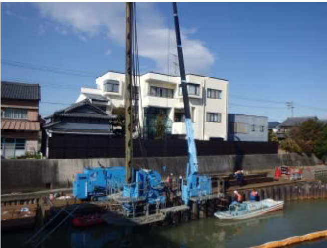
○鋼矢板圧入状況
