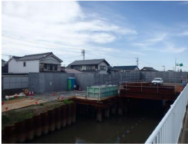
○防音シートによる騒音対策
