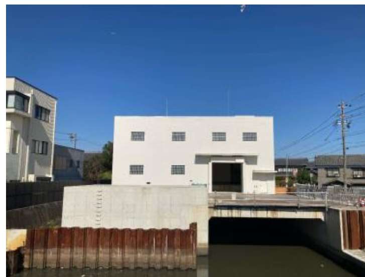
前野排水機場(新設)
