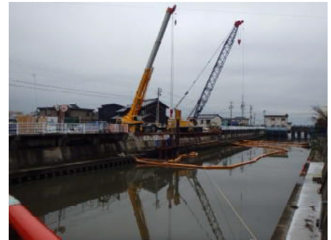
○汚濁水の流出防止対策
