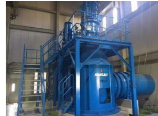
立軸斜流 \phi 1,200 \times 2 台
