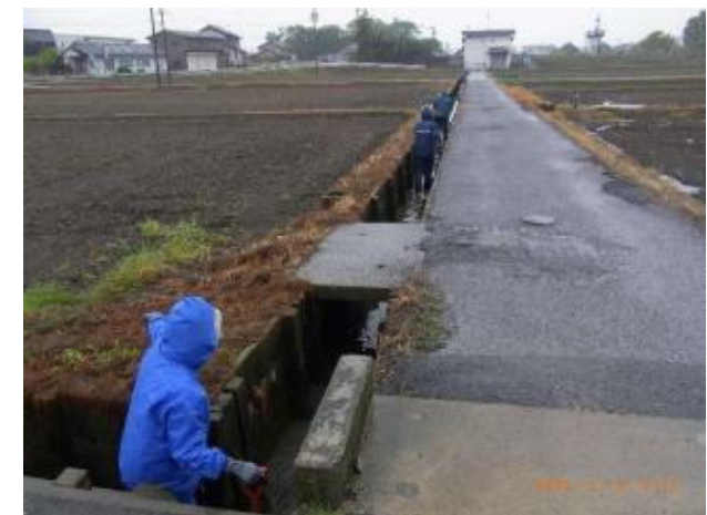
排水路の清掃
