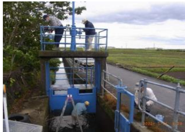
ゲートの点検・清掃
