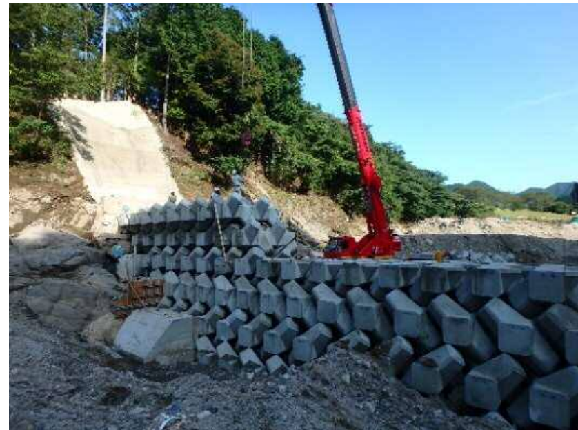
ブロック積（1号貯砂堰堤）
