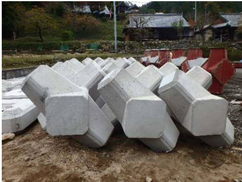
ブロック積（1号貯砂堰堤）
