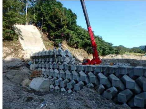
ブロック積（1号貯砂堰堤）
