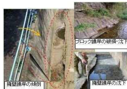
第三頭首工護岸の状況
