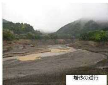
安濃ダム上流部の堆砂状況
