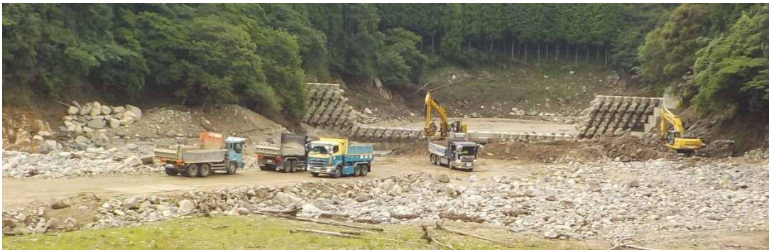
堆砂除去状況（1号貯砂堰堤）
