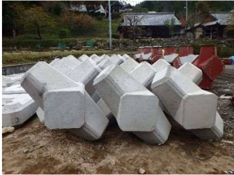
ブロック積（1号貯砂堰堤）
