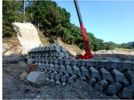
ブロック積（1号貯砂堰堤）
