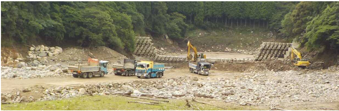
堆砂除去状況（1号貯砂堰堤）
