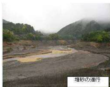
安濃ダム上流部の堆砂状況
