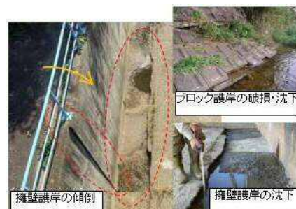
第三頭首工護岸の状況
