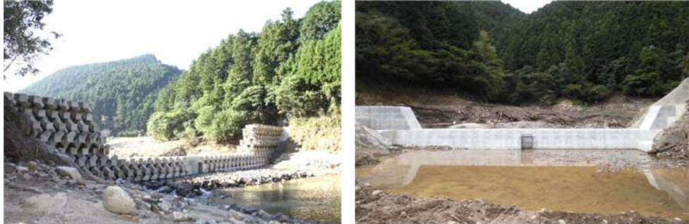
ブロック積み構造・スリット（1号・2号貯砂堰堤）
