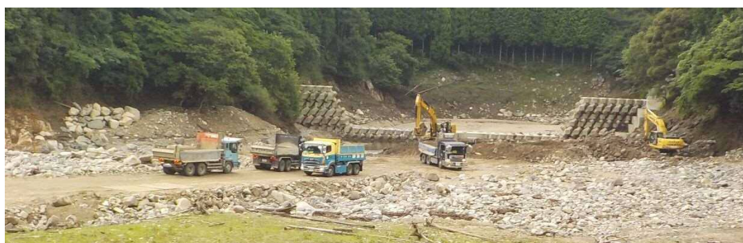
堆砂除去状況（1号貯砂堰堤）
