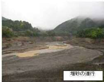
安濃ダム上流部の堆砂状況
