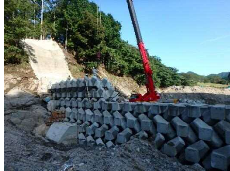
ブロック積（1号貯砂堰堤）
