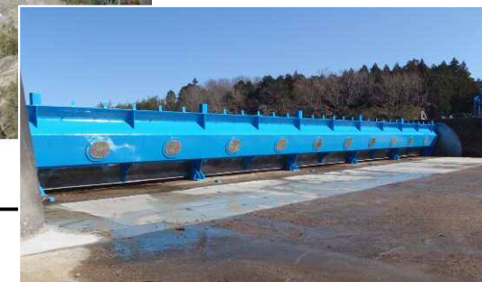
洪水吐ゲート再塗装 ・エプロン補修
