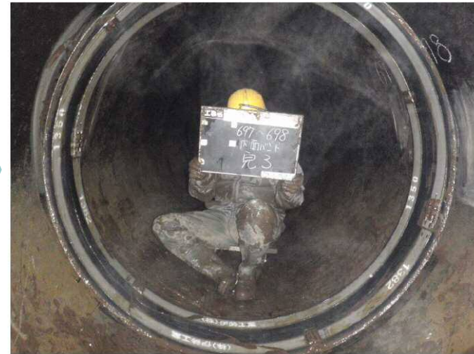
止水バンド設置
