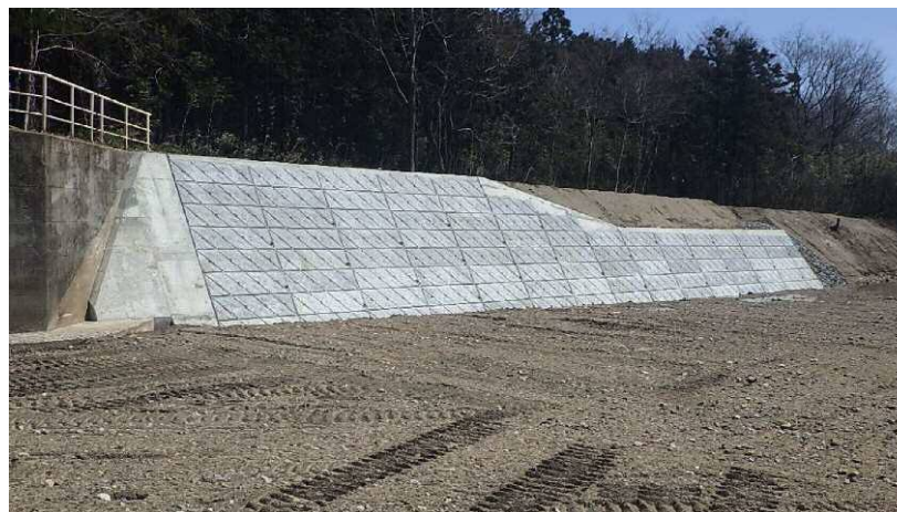
左岸護岸（完了）
