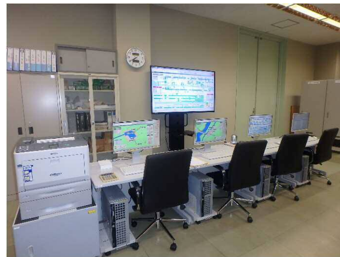
水管理施設（更新後）
