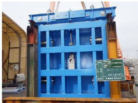
＜非常用ゲートの更新＞
