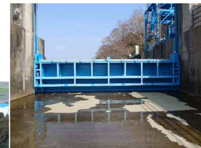
土砂吐ゲート 再塗装
