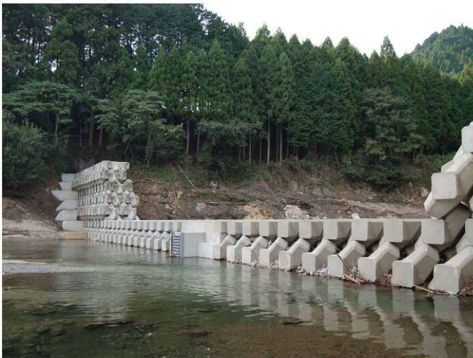
＜1号貯砂堰堤の造成＞
