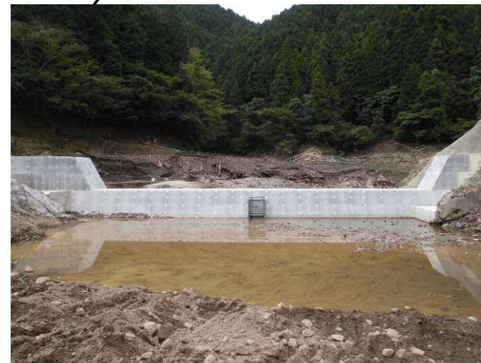
＜2号貯砂堰堤の造成＞
