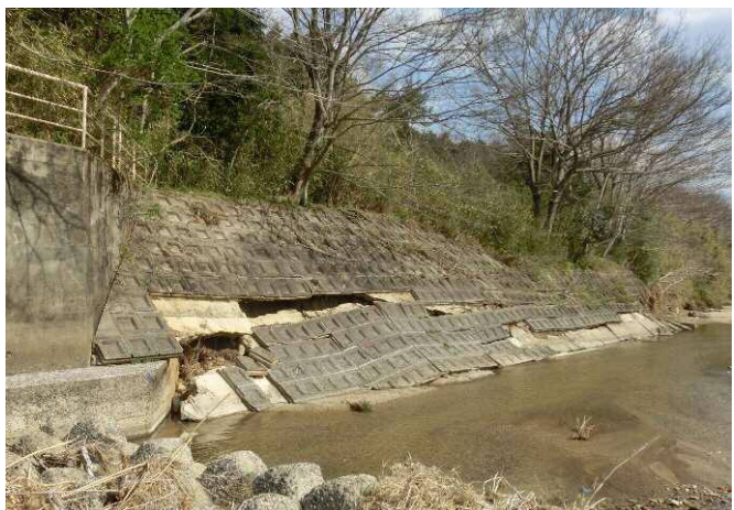
左岸護岸（復旧前）
