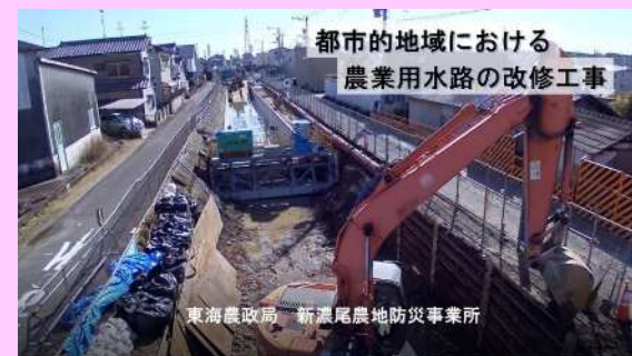
都市的地域における農業用水路の改修工事
