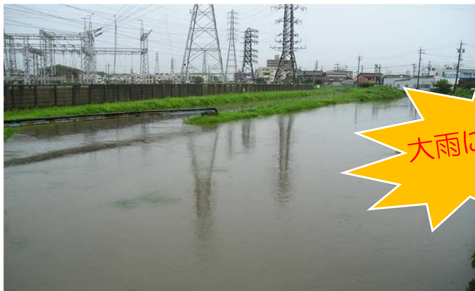
＜ 大江排水路からの溢水 ＞
