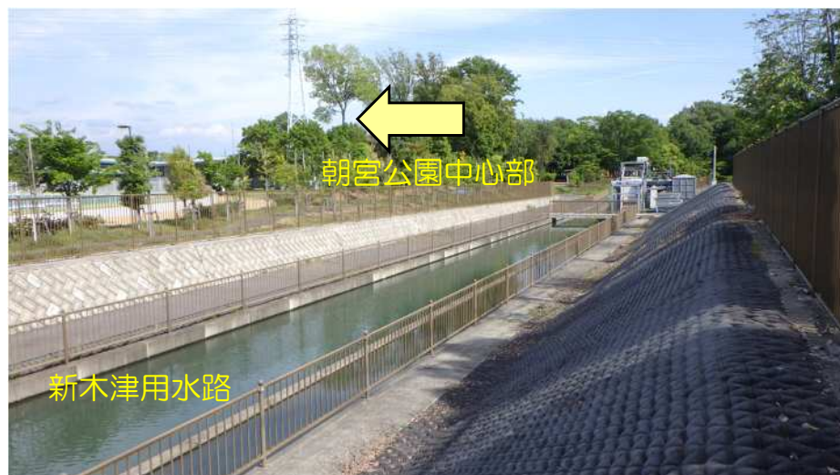
春日井朝宮工区 (H28年度施工区間)
