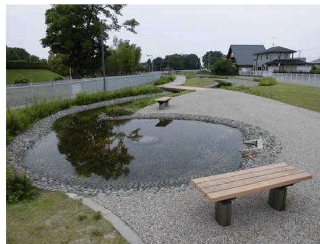
宮田導水路の上部利用 （蘇南公園横）
