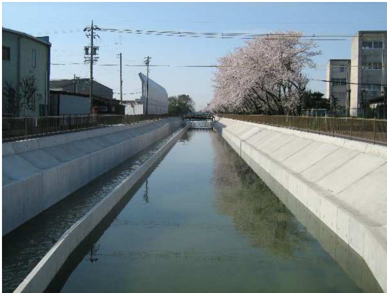
木津用水路 (改修後)
