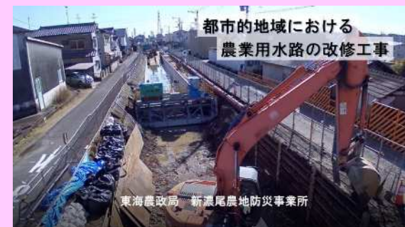
都市的地域における農業用水路の改修工事
