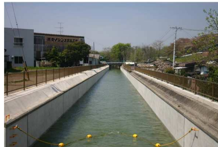
宮田導水路 (改修後)
