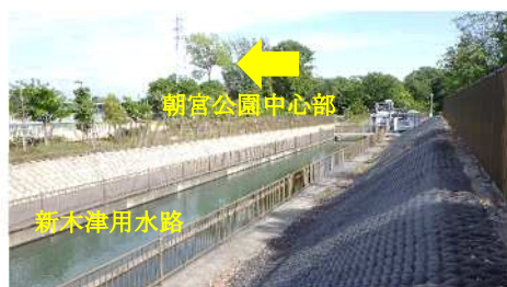
春日井朝宮工区(H28 年度施工区間)
