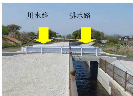
工事実施後(用水路暗渠化)
