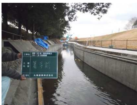
工事実施前(開水路部分)
