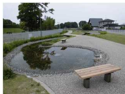
宮田導水路の上部利用(蘇南公園横)
