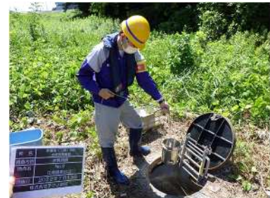
江南暗渠出口地点
