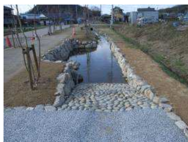
用水路上部のせせらぎ水路
