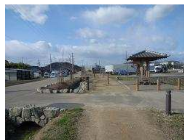
景観に配慮した休憩施設と遊歩道
