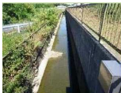
蓋掛け工事 着手前
