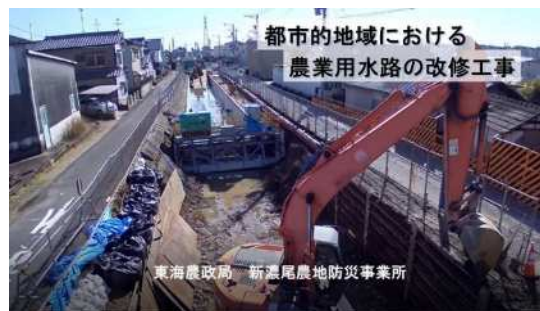
都市的地域における農業用水路の改修工事の動画
