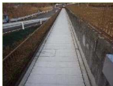
蓋掛け工事 着事後
