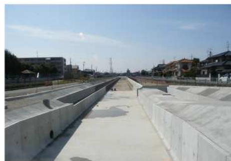
木津用水路(改修後)
