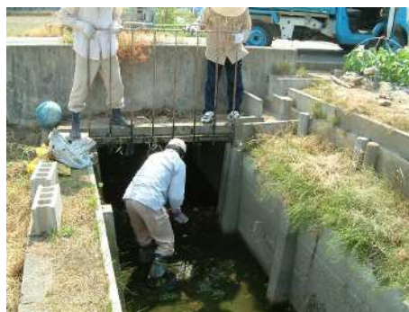
水路の泥上げ(清須市)
