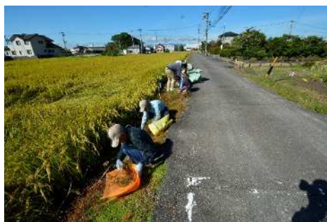
イワダレソウの植栽及び法面の草取りの作業風景
