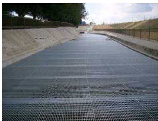
工事実施後(開水路部蓋掛け)
