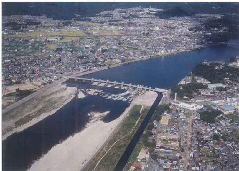
施工前の全景
