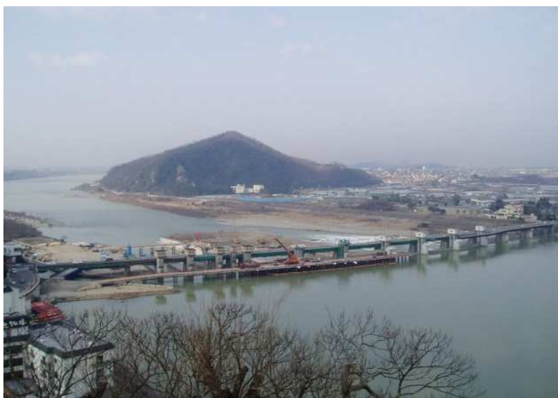
施工中 (犬山城より)
