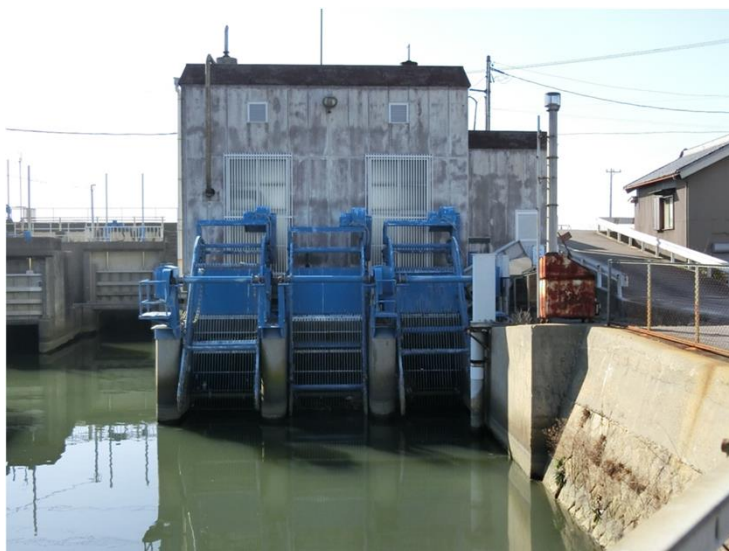
高島排水機場(撤去)
