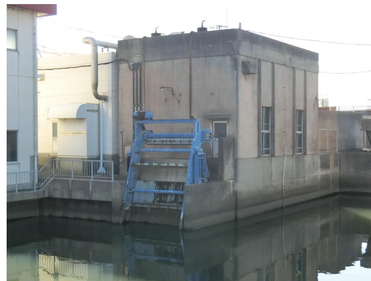
横須賀排水機場(撤去)
