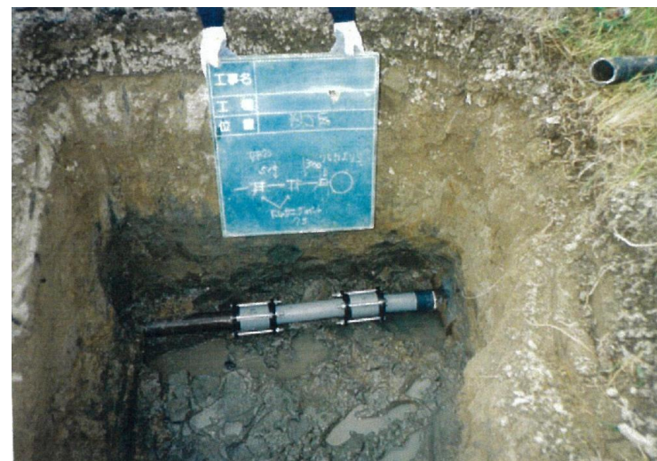
石綿セメント管の補修状況
