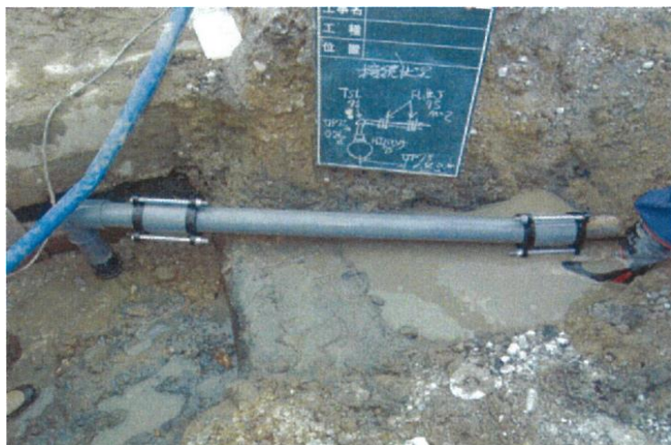
石綿セメント管の補修状況
