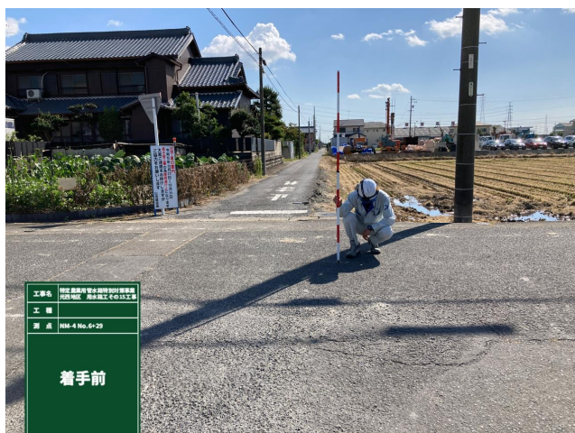
大海用鍋蓋工区路線（住宅近接）
