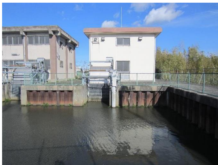
牧川第二排水機場(廃止)
