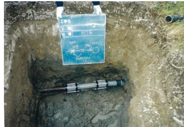
石綿セメント管の補修状況
