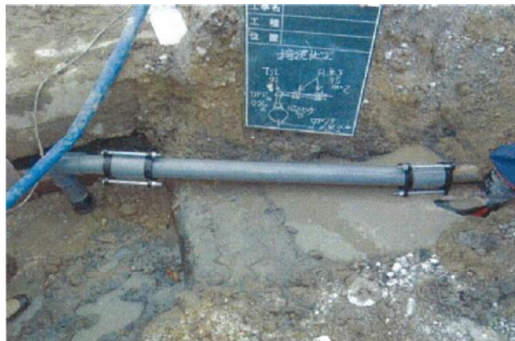
石綿セメント管の補修状況
