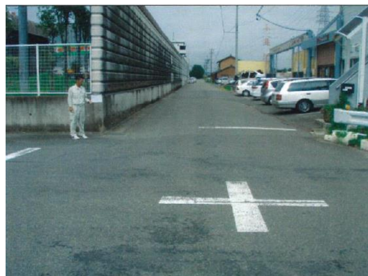
大海用鍋蓋工区路線(住宅近接)
