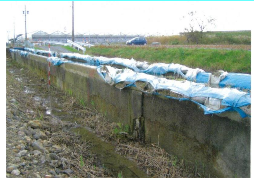
用水路の嵩上げ
