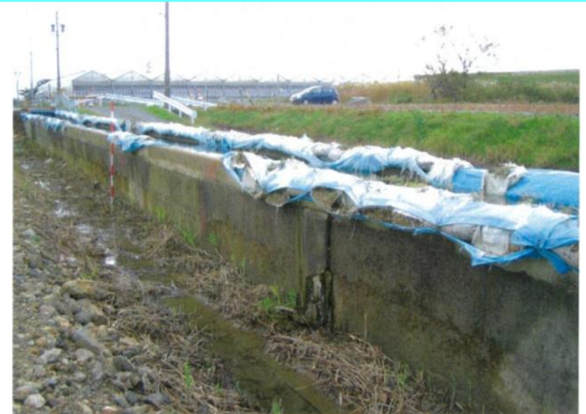
用水路の嵩上げ
