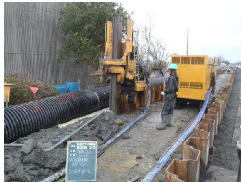
油圧式杭圧入引抜機による仮設鋼矢板の引抜き
