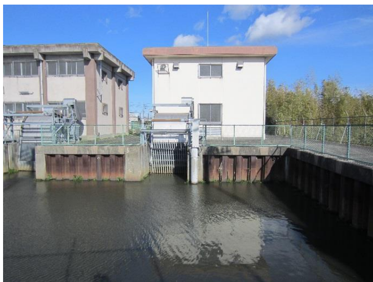
牧川第二排水機場(廃止)
