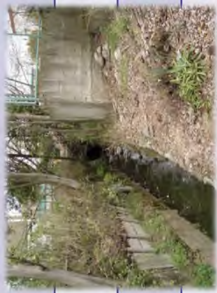
石積が水路内に流出した排水路(実施前)
