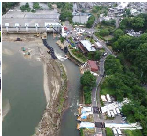
仮設ポンプ設置状況 取水工 (5月29日時点) (漏水発生 (5月15日) から14日経過)
