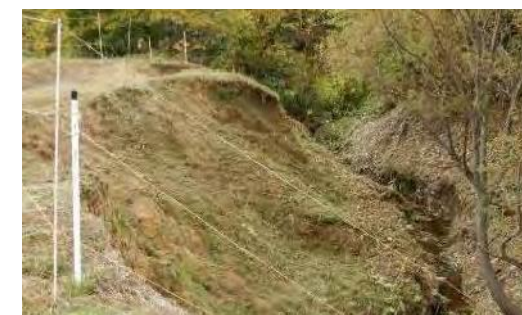
土水路の法面崩壊
