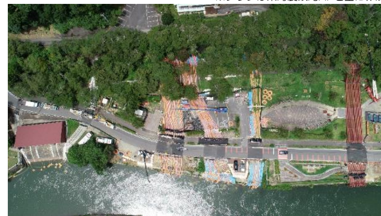
仮設ポンプ設置状況 右岸上流 (7月29日時点) (漏水発生 (5月15日) から75日経過)
