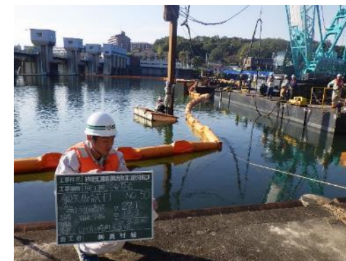
汚濁防止フェンス
