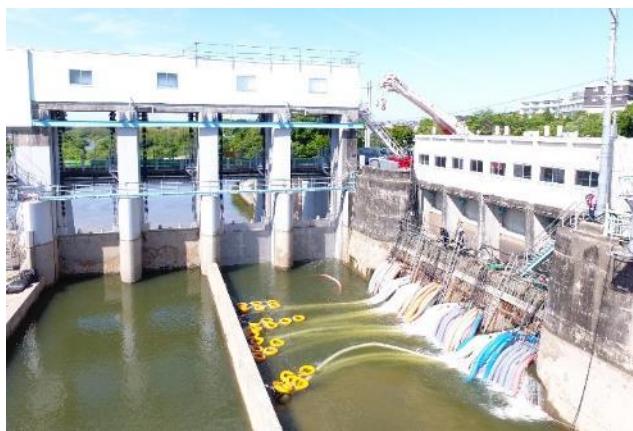
仮設ポンプ設置状況 取水工 (5月29日時点) (漏水発生 (5月15日) から14日経過)
