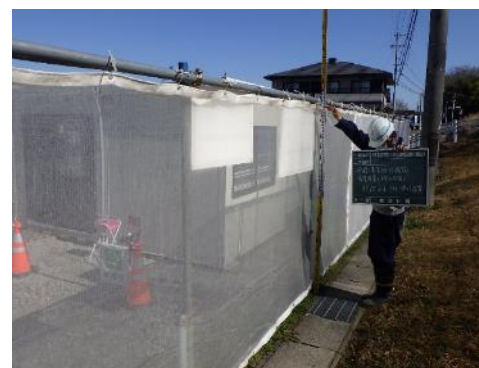
防塵ネットの設置
