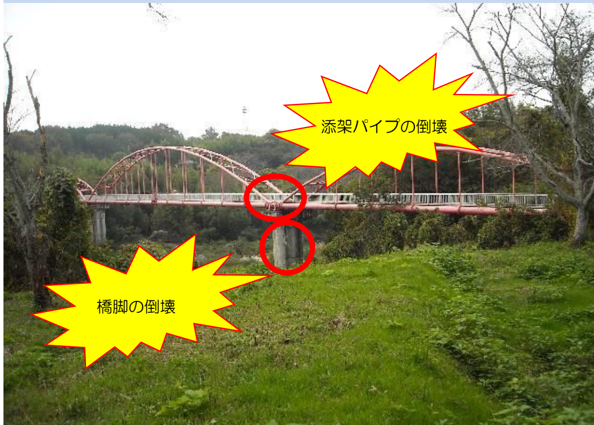
豊田幹線水路（勘八水管橋）
