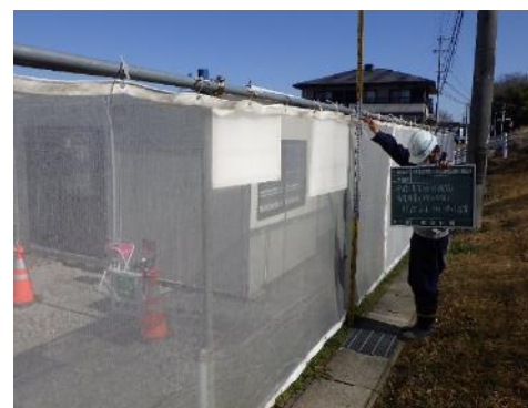
防塵ネットの設置
