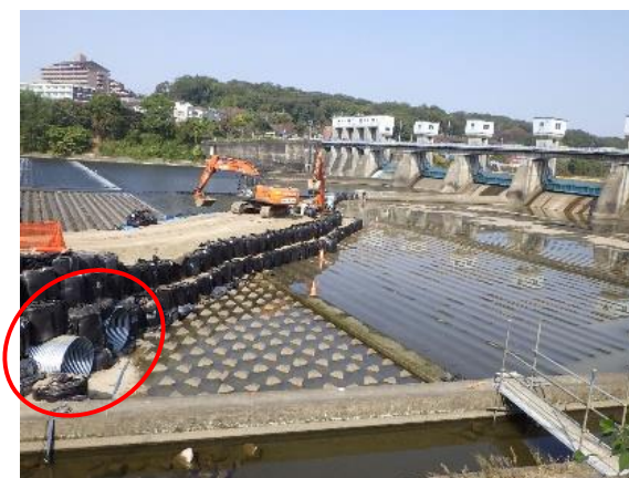
頭首工左岸側の仮設魚道 （コルゲート管）
