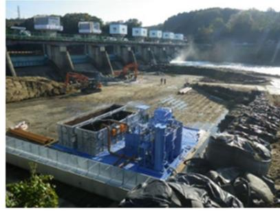
右岸仮締切内の汚濁水処理設備
