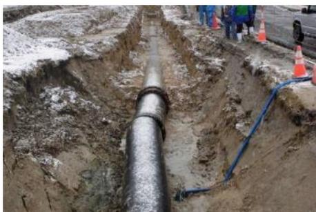
地震による継手の破損
