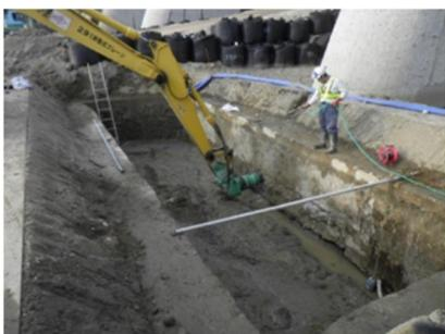
コンクリート取壊し時の散水
