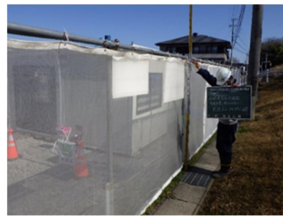
防塵ネットの設置状況
