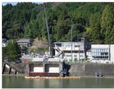
取水工へのシルトフェンス設置状況
