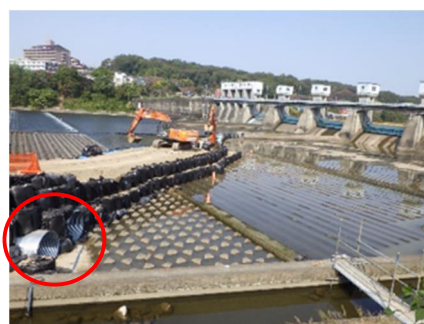
工事左岸側の仮設魚道 (コルゲート管)
