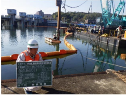
汚濁防止フェンス(上流矢板試し打ち)
