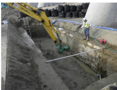
コンクリート取壊し時の散水
