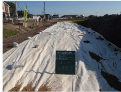
土木シート敷設状況
