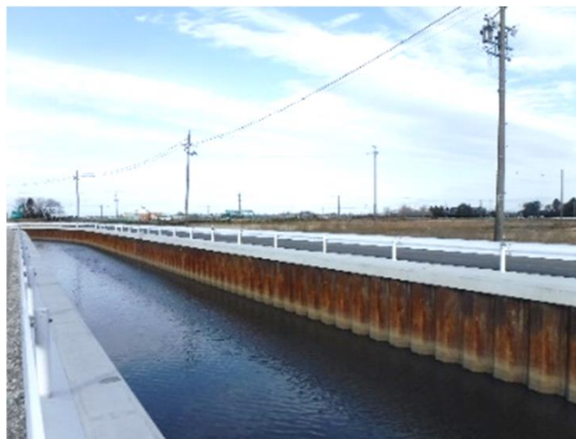
鋼矢板護岸排水路（改修後）
