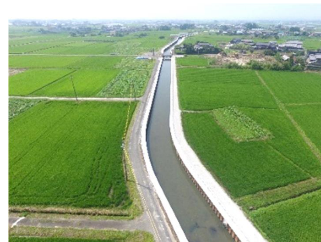
排水路前景（改修後）
