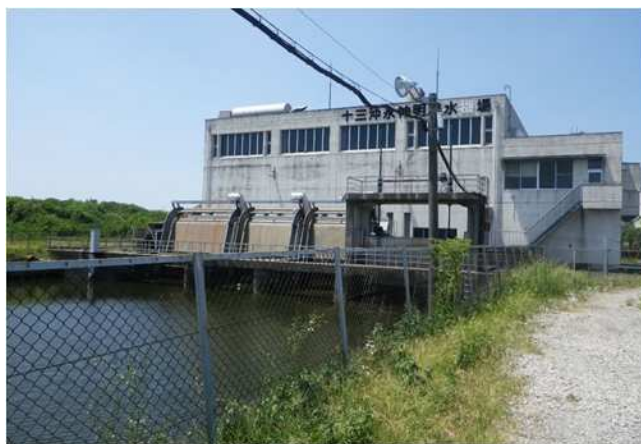
十三沖永神明排水機場(廃止)
