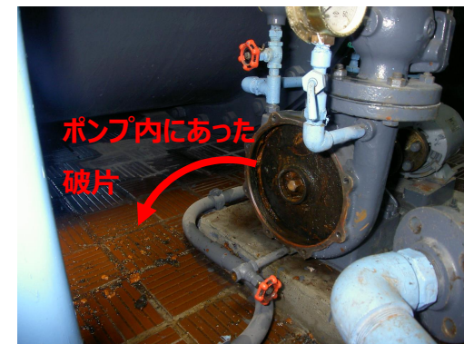
注水ポンプ分解
