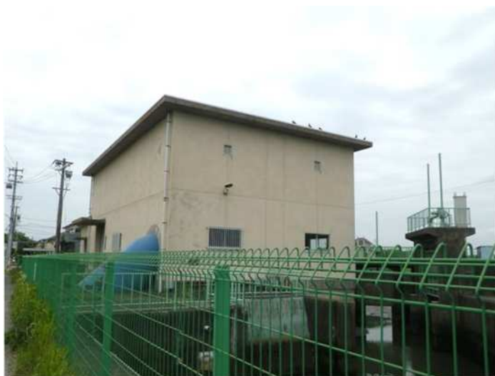
阿久比排水機場(撤去)
