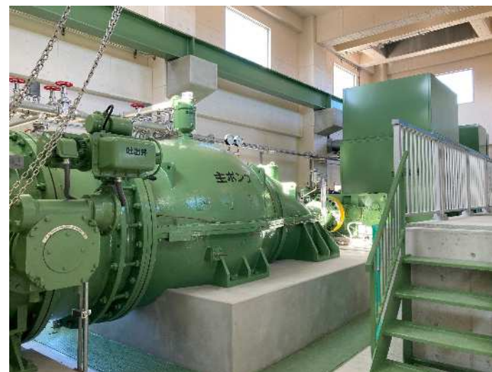
植大排水機場(新設)
