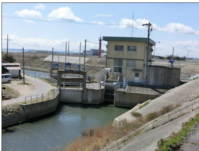
大岡排水機場（既設）
