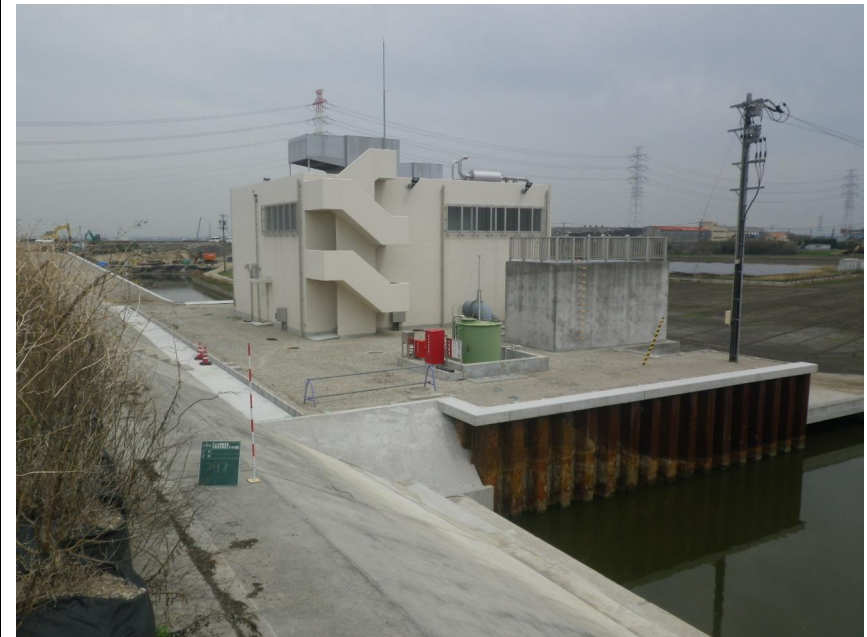
ハット型鋼矢板打設状況
