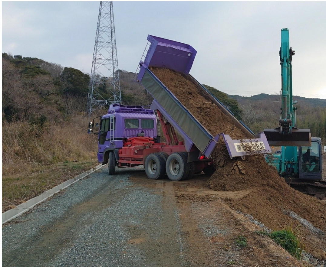
他地区へ発生土運搬状況
