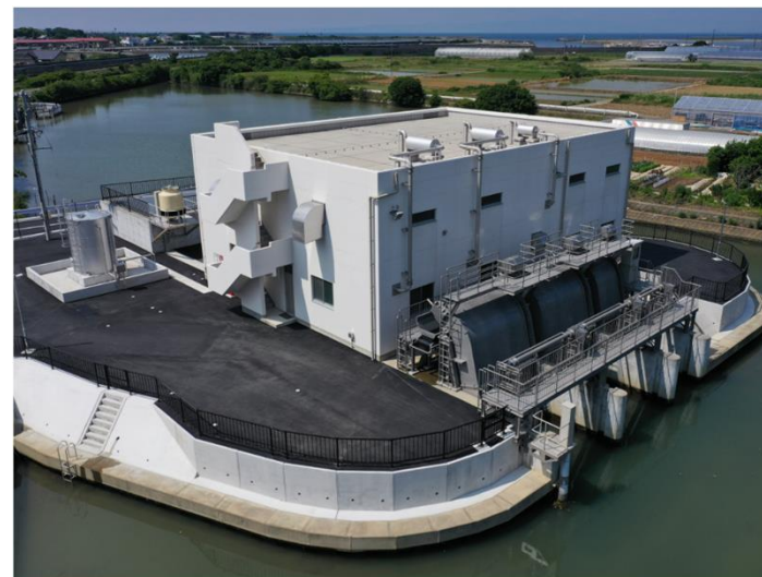
新天白排水機場（新設）
