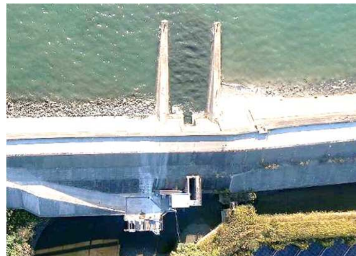
西実録第2樋門
