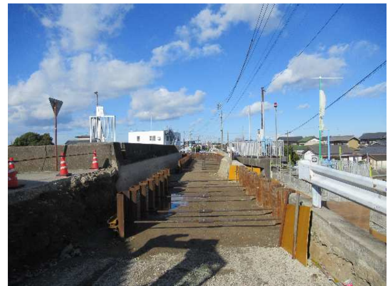
同調施工(酒手島樋門) 手前側が農地海岸、奥側が建設海岸
