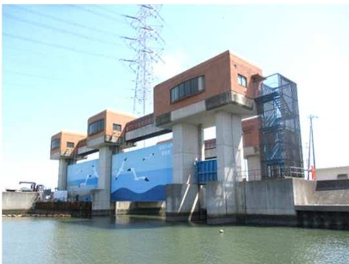
北浜川排水樋門
