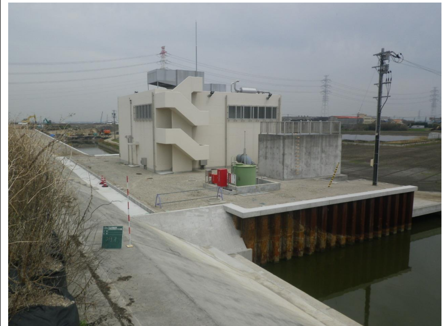
ハット型鋼矢板打設状況
