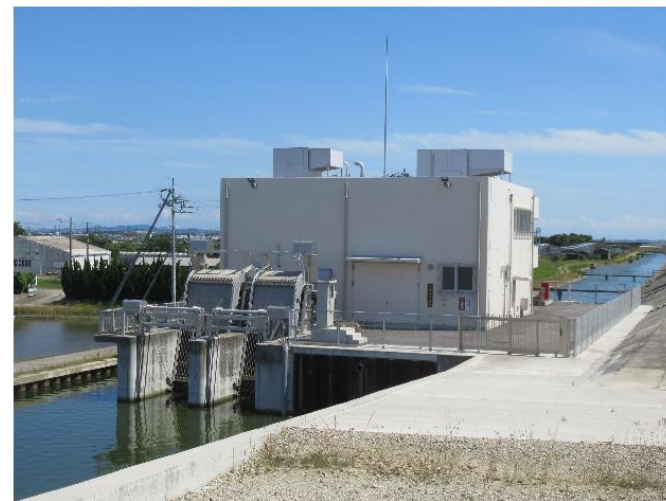
大岡排水機場（新設）
